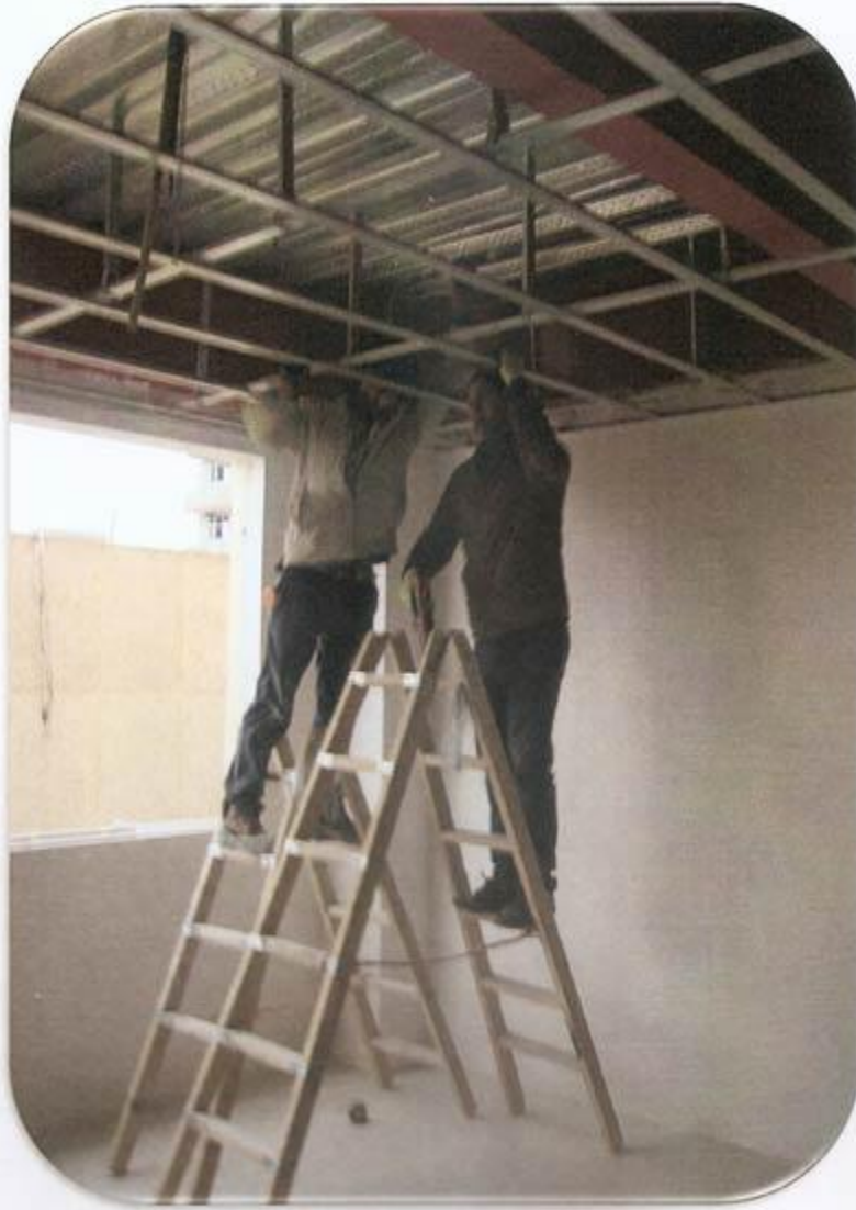
عبور لوله و سیم برای اجرای چراغ هالوزن
