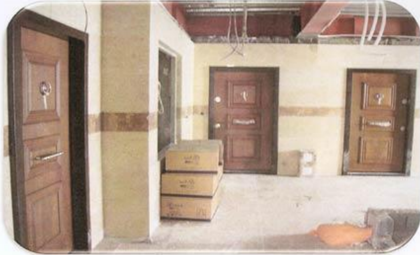
نصب درب ورودی واحدها طبقه ۱۰
