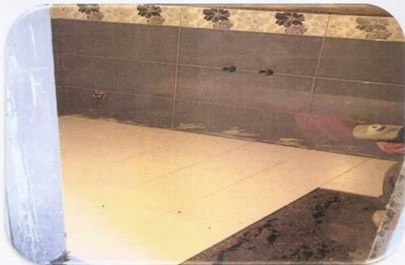
اجرای کاشی و سرامیک حمام مستر واحد A طبقه ۱
