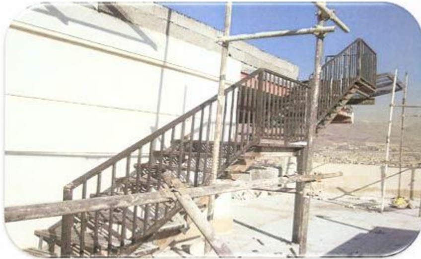
نصب نرده های پد
