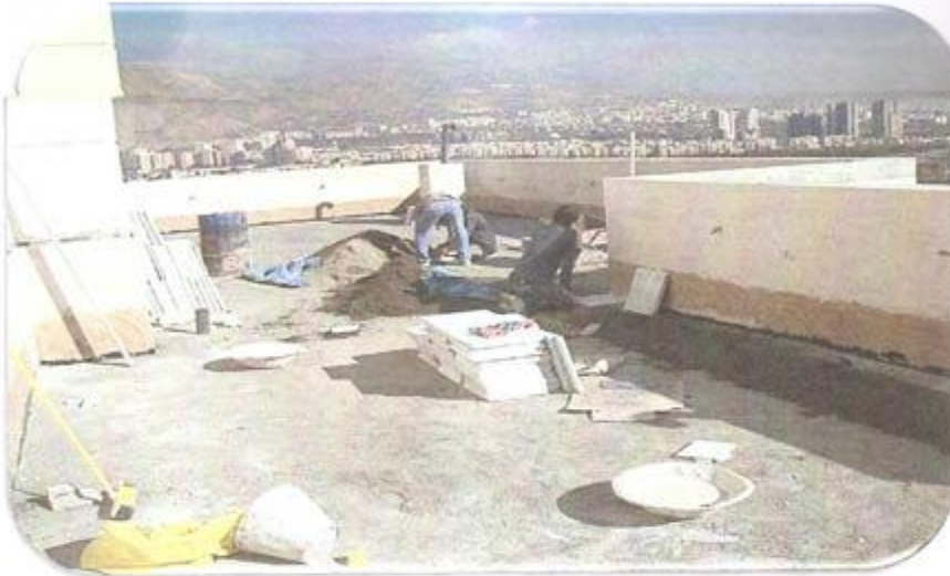
اجرای سنگ کف، پام طبقه ۱۷ ضلع شرقی
