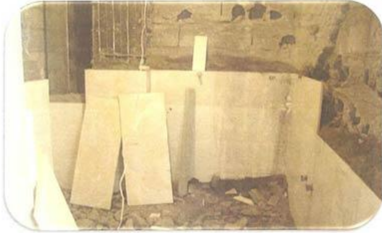
اجرای کاشی سرویس حمام مشترک طبقه ۱۹
