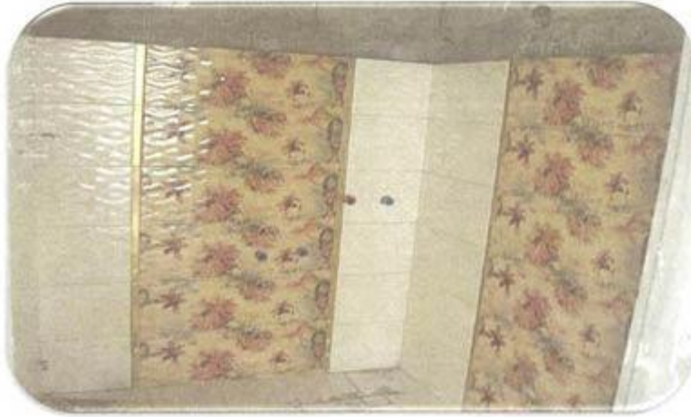
اجرای کاشی سرویس حمام مشترک طبقه ۱۶ واحد F
